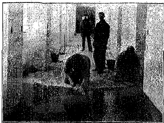
Fig. 8. Støbeasfalts Udlægning.
